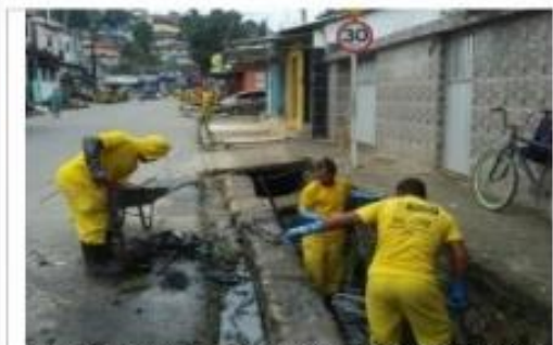
LIMPEZA DE ESTRUTURA DE DRENAGEM
